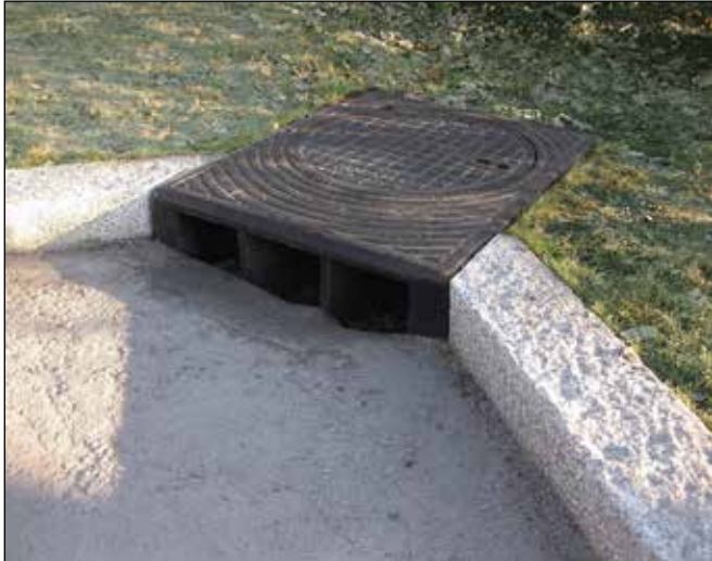
Säädettävä kitakaivo 680 x 830 mm ns. kelluva
