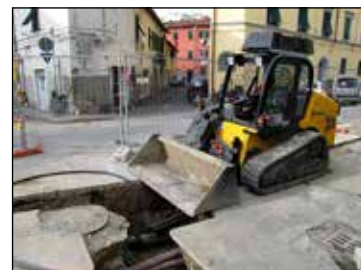
Korotusrenkas on tarkoitettu jo olemassa olevan kaivon korottamiseen.
