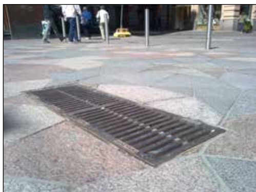
Jupalco sadevesikansisto Keskuskadulla hiekaneräysastiolla varusteltuna.
