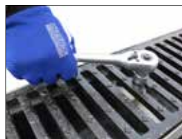
Sadevesikansissa / ritilöissä pulttikiinnitys
