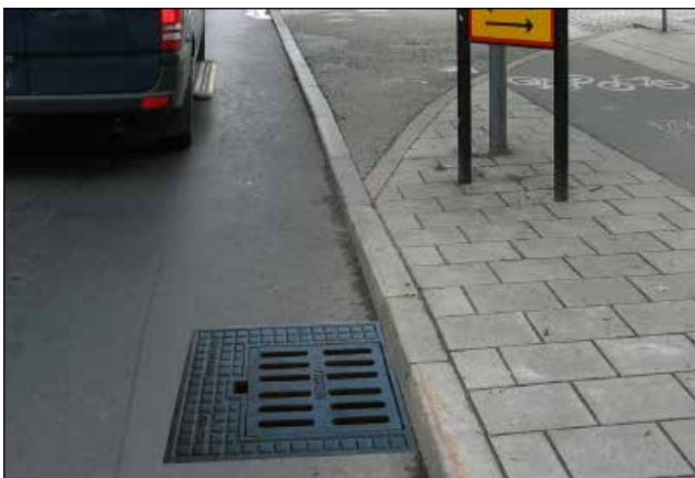
Jupalcon ASY - kansisto asennettuna reunakiven viereen.
