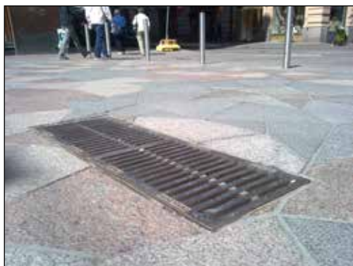
Jupalcon suorakaidekansisto asennettuna Helsingin Keskuskadulle.
