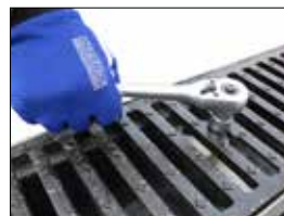
Sadevesikansissa / ritilöissä pulttikiinnitys
