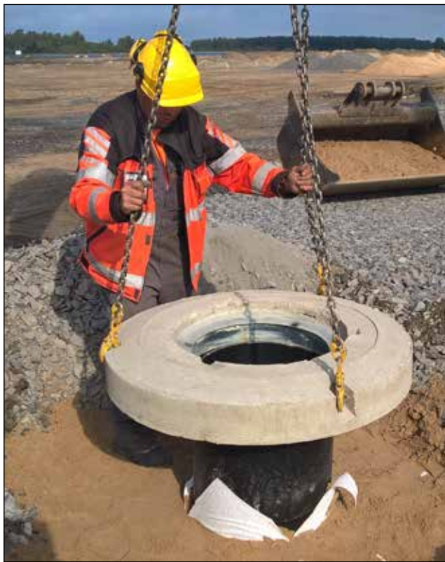
Betonisen perustuksen asennus muoviputkelle Ø 500 mm.
