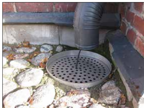
Sadevesikaivo. Kaivoon asennettu hiekankeräysallas \varnothing 445 mm
