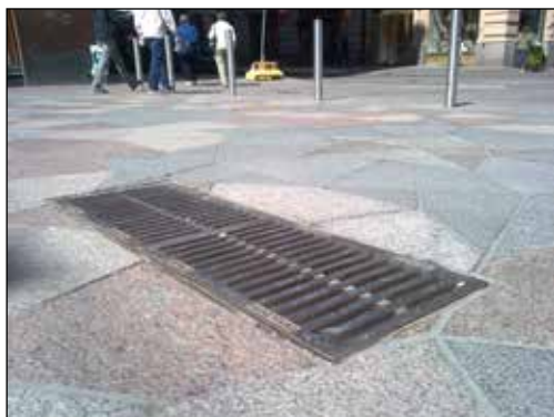
Jupalcon suorakaidekansisto asennettuna Helsingin Keskuskadulle.
