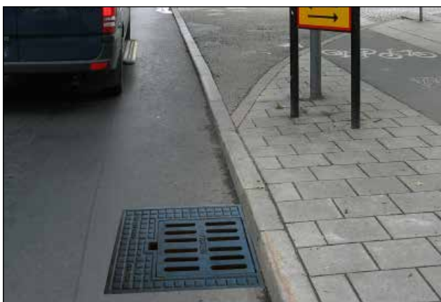
Jupalcon ASY - kansisto asennettuna reunakiven viereen.
