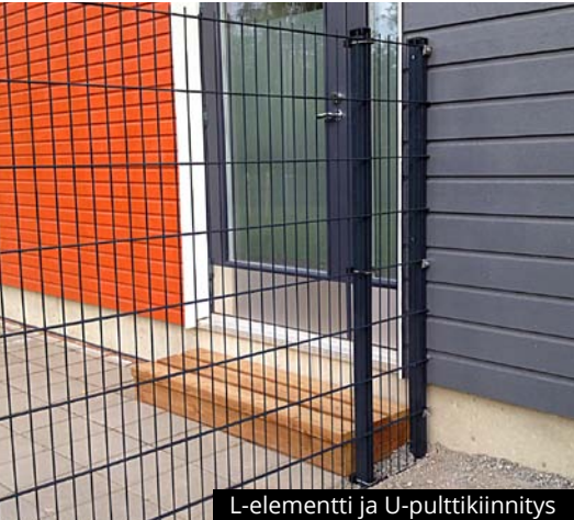
L-elementti ja U-pulttikiinnitys
